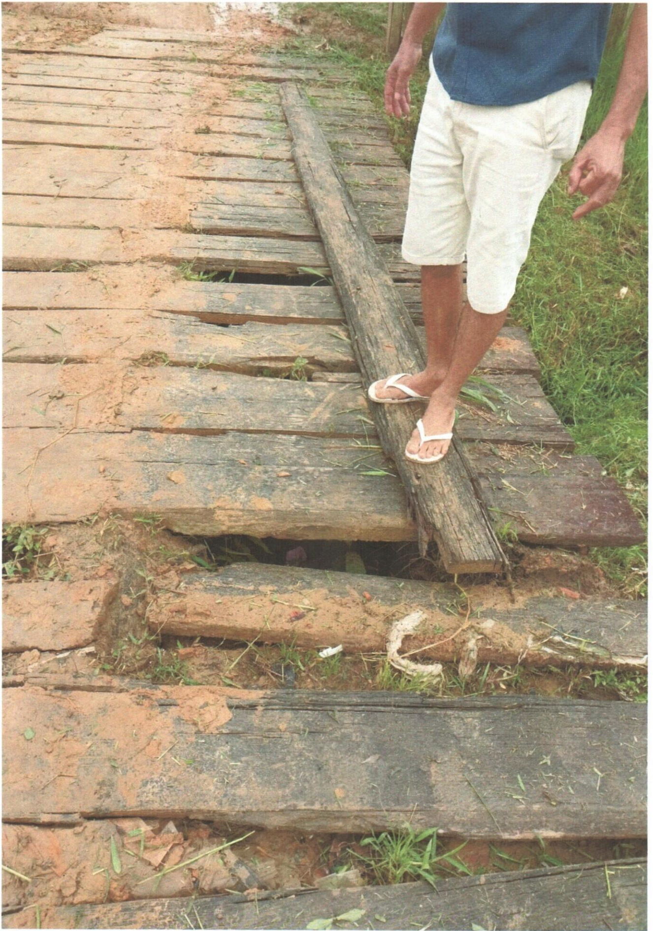
Ponte do Bairro Ouro Verde – Pauini – Amazonas
