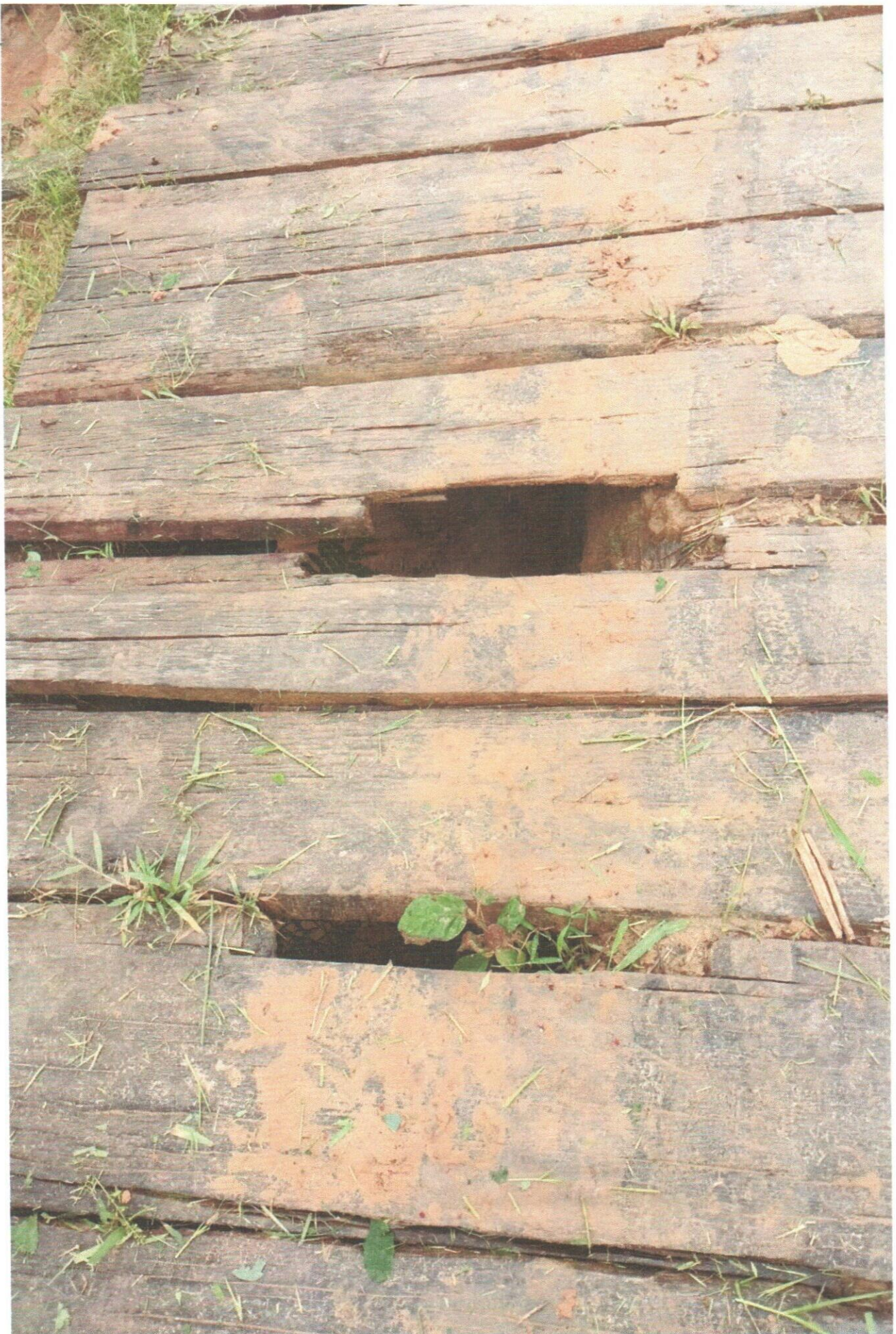
Ponte do Bairro Ouro Verde – Pauini – Amazonas
