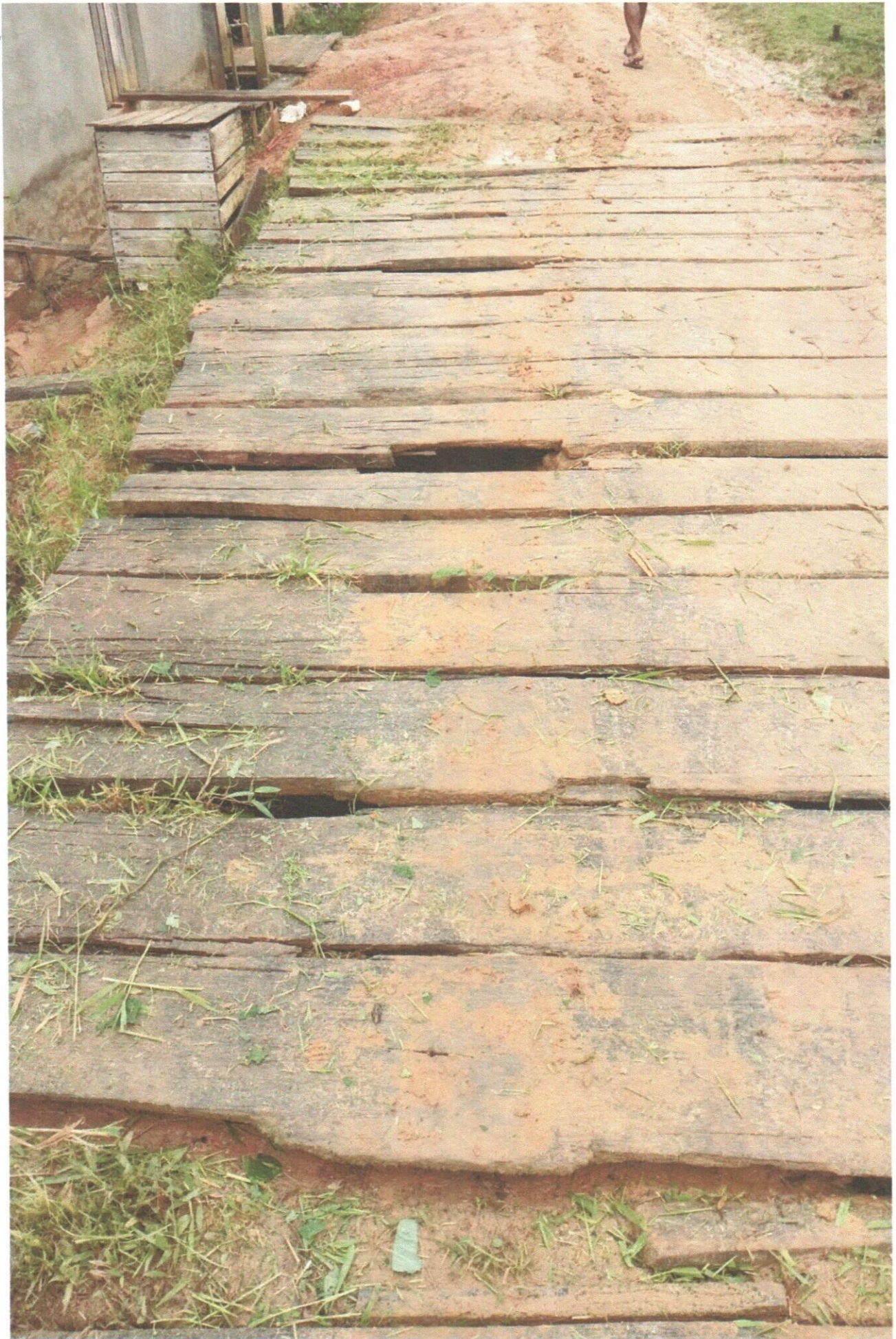
Ponte do Bairro Ouro Verde – Pauini – Amazonas
